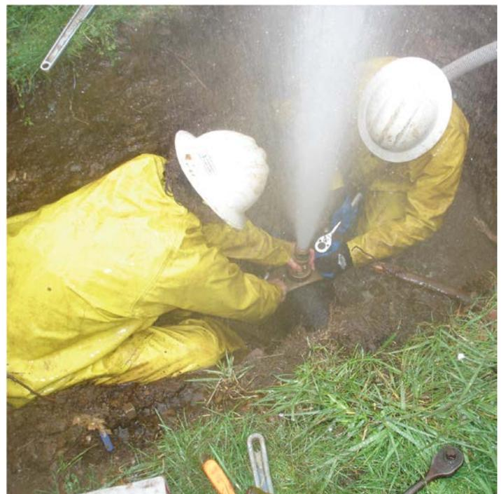
Equipo de distribución reparando la rotura de la cañería maestra en Holman & Oberg. 7
